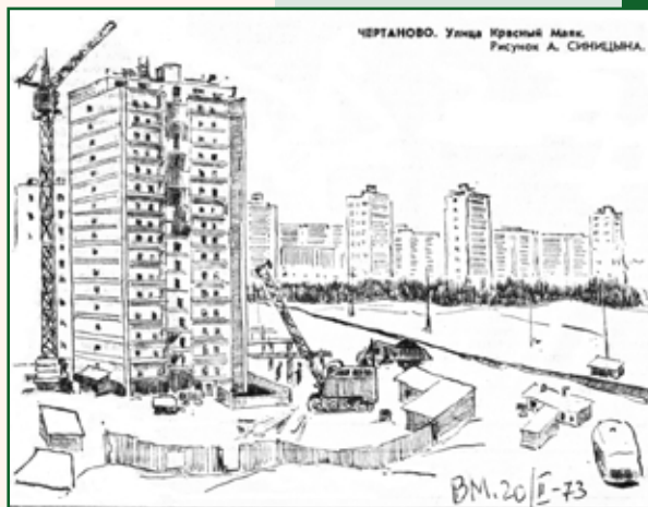
Строительство на улице Красного Маяка, 1973 год (рис. А. Сеницына в газете «Вечерняя Москва» от 20.02.1973)
